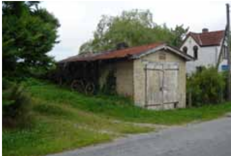
Brandstationen på Diernæsvej.
